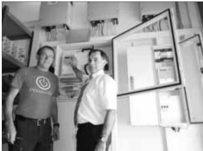
Betriebsleiter Kläranlage Wolfgang Wild und Bürgermeister Günther Pfefferer bei der offiziellen Inbetriebnahme
