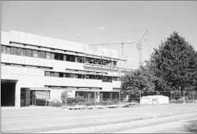
Sanierung der Grund- und Hauptschule
