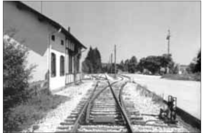
Der Endbahnhof Monheim (Schwab) – (Blick aus Richtung Fünfstetten). Links ist der Lokschuppen zu erkennen.
